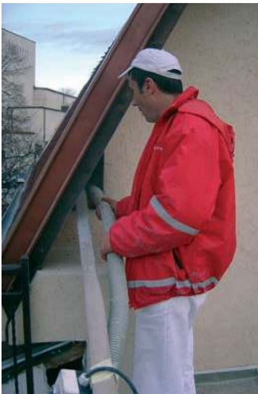
Монтаж в подпокривно пространство гр. Банско
