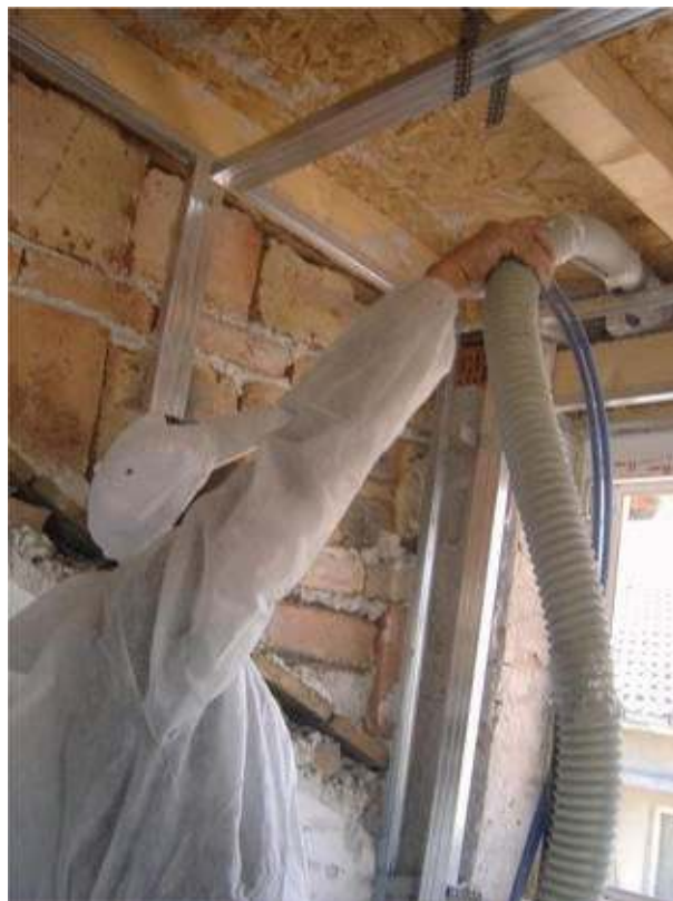
Монтаж в таван над конструкция гр. Плевен
