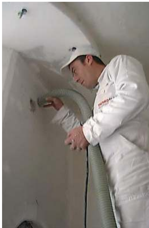
Монтаж в подпокривно пространство гр. Варна
