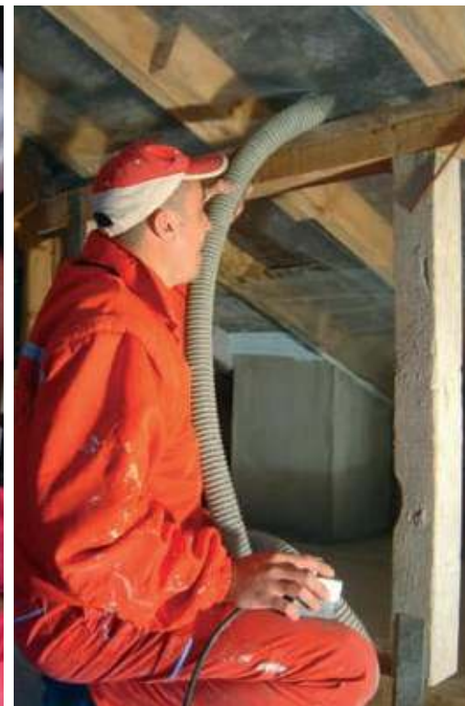
Монтаж в стенна обшивка гр. Банско
