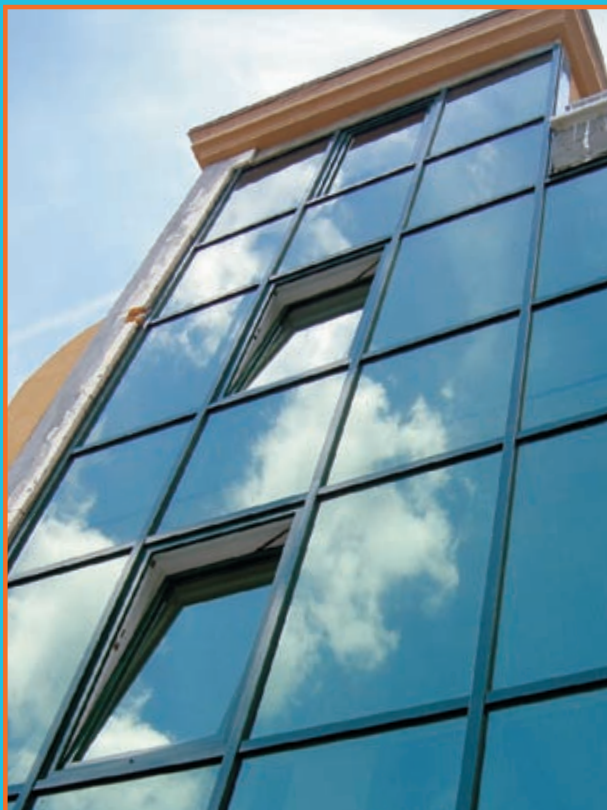
Окачена фасада на бизнес сграда "Аметист" гр. Варна
